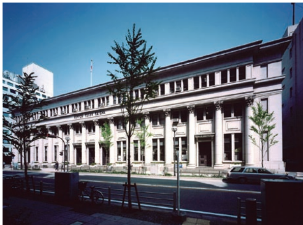
1936 (昭和11) 年竣工の横浜郵船ビル1階部分を2003 (平成15) 年に博物館として改修しました
