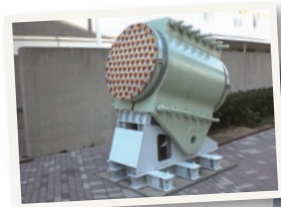
明石海峡大橋 ケーブル&ケーブルバンド
