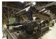
大型のコンプレッサー
