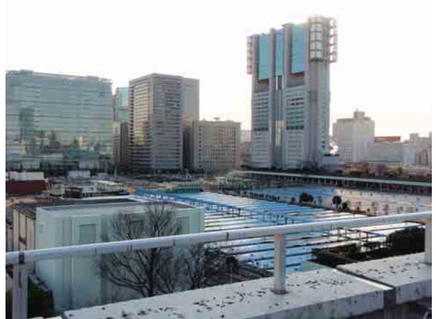
図4 下水処理施設（反応槽）遠景
