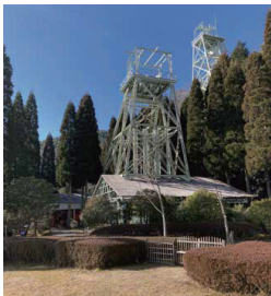
第一竖坑と第十一竖坑
