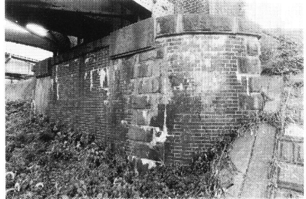
写真 24 高瀬川橋梁下り線橋台
