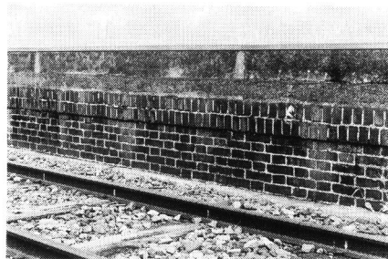
写真32 布施屋駅プラットホームのフランス積み
