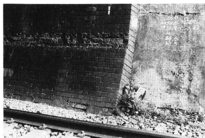
写真8 高御所トンネル下り線の側壁に見られるフランス積み
