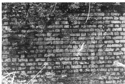
写真30 福知山線の土留擁壁に見られるフランス積み
