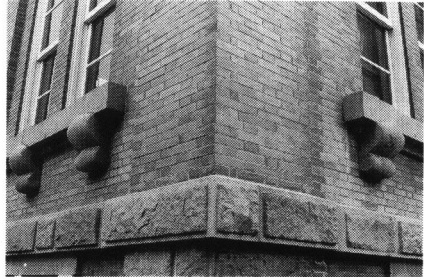
写真3 両側面に羊羹を挟んだ旧・北海道庁本庁舎の端部の仕上げ
