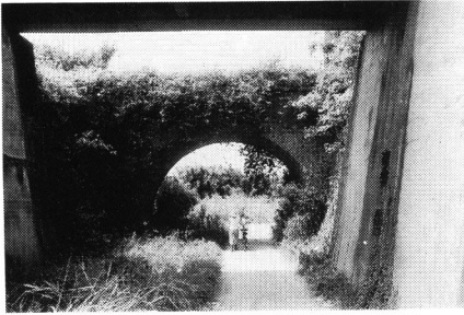
写真 17 旧・矢部川避溢拱渠
