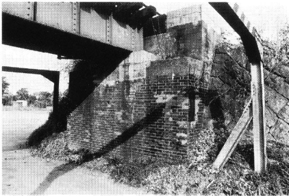
写真 27 永井川橋梁橋台
