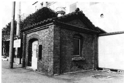
写真4 藤枝駅危険品庫
