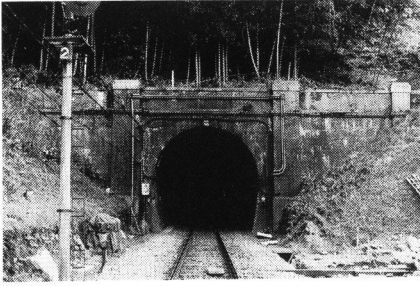
写真 11 亀山トンネル
