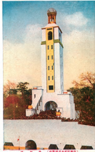
05 【(平和記念東京博覧會) 平和塔】 現在の清水観音堂の西に位置し、第二会場への入り口となる建物。斜路を用い第一会場と第二会場との高低差を埋める歩道橋の役割も果たした 12) 。
