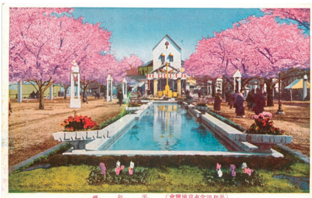
01 【(平和記念東京博覧會) 平和館】 本博覧會のテーマである「平和」の象徴として作られ、映画・講演・コンサートの会場として使われた。正面の「甍」(切妻部分)に平和の鐘をつるして鳴らし、入り口の両側には新海竹太郎の手になる「平和の女神像」が設置された。現在の竹の台広場の、噴水のあたりに建設された 8) 。
