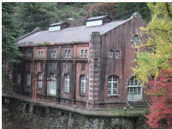
べっしどうざん 別子銅山 (愛媛県) を支えた旧端出場水力発電所 きゅうはでば (1912年建屋完成。1970年発電所廃止)
