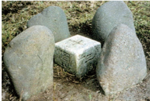
図8 三角点と4つの保護石 三角点上面の十字の中心の経緯度の値が求められている。
